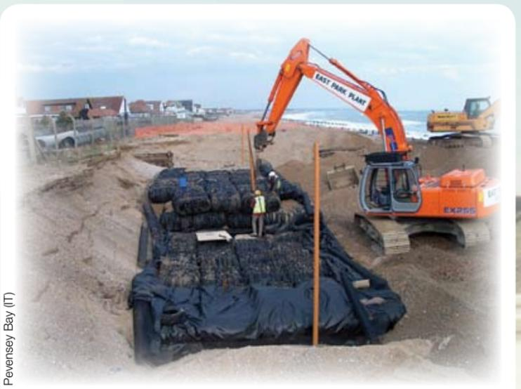
De nouvelles techniques sont tentées afin de renforcer nos plages et réduire la quantité de galets nécessaire pour le rechargement. Par exemple, de vieux pneus usés ont été utilisés pour renforcer la plage à Pevensey.
